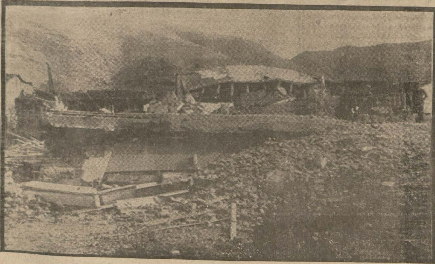
Tokada'da sinema binası ile civarındaki binalar taş ve toprak yığını halinde
